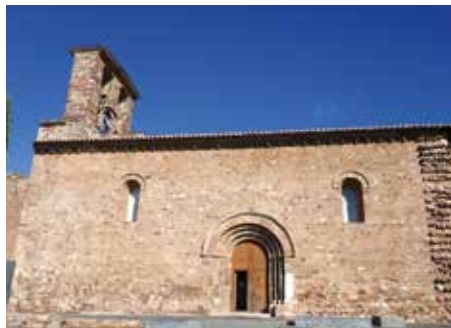
6. Sant Pere. Façana principal.
