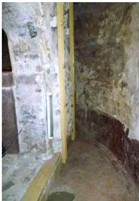
Fig. 26. Paviment d' opus signinum i un sòcol vermellós de l'enlluït original de l'absis de Sant Pere.
