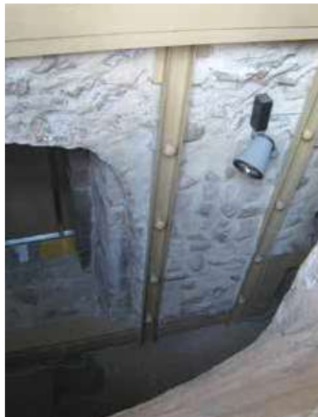
Fig. 4. Estructura metàl·lica de reforç instal·lada al retaule. MdT.
