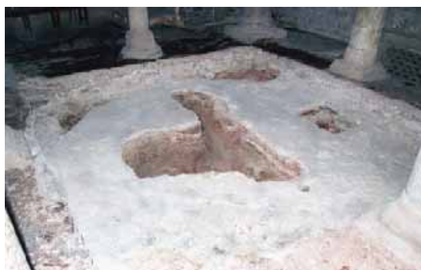
Figura 11. Niveles de cal extendidos durante el proceso constructivo en el centro del edificio y cimentaciones corridas de la columnata (archivo Museo de Terrassa).
