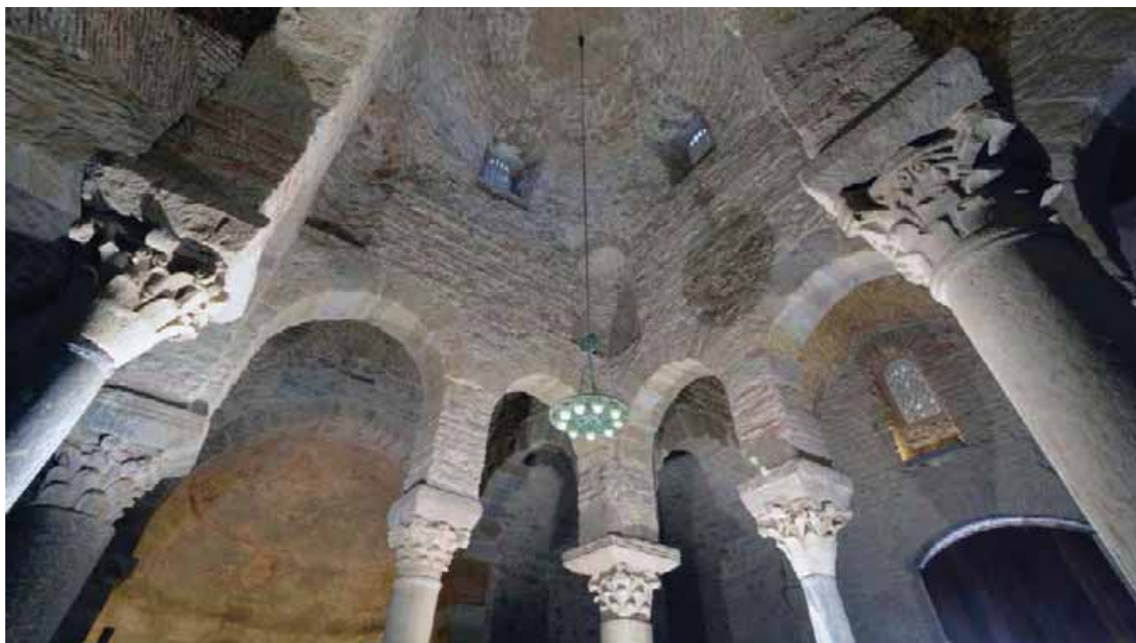
Figura 12. Detalle de los elementos de soporte de la cúpula central (Archivo ICAC - J. M. Macías).
